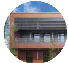
URBAN VALLEY, Massy, Bâtiment B - France
