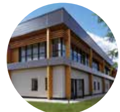
TECHNOPARC DE LAMIRAULT, A et B, Collégien - France
