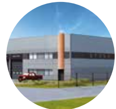
ACTI, Mitry-Mory, Bâtiment B - France
